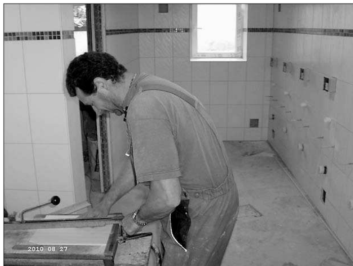
Fliesenarbeiten im Herren-WC
