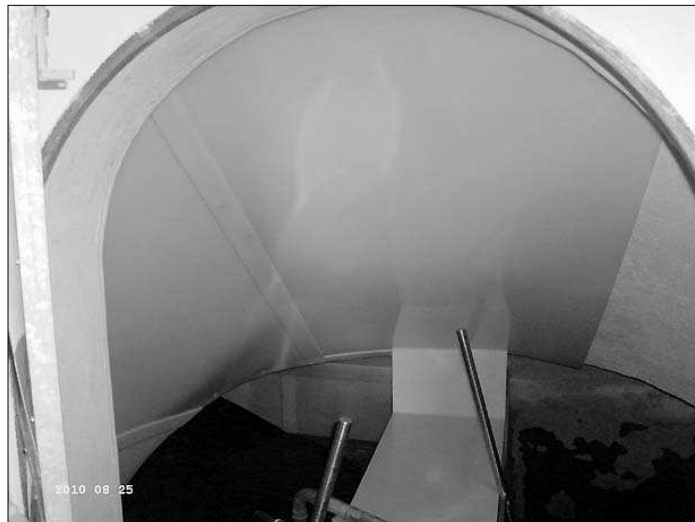
Blick in das sanierte Behältergewölbe
