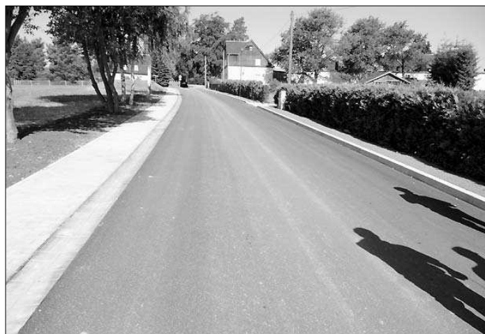
Die neu ausgebaute Waldstraße in Birkenhügel
