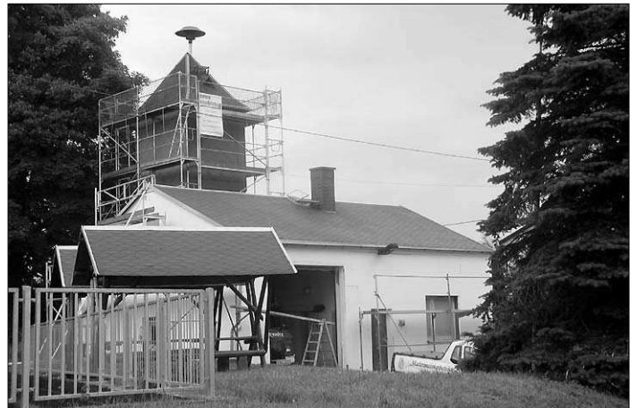
Dämmarbeiten am Gebäude
